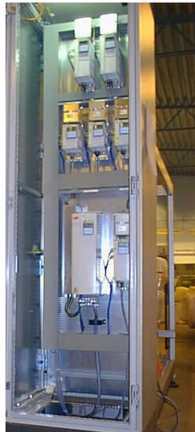
Figur 37 Elskåp 3 med frekvensomformare från ABB. Den största nederst är till kompressionsmotorn.
