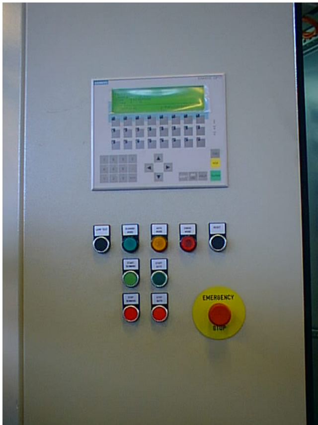
Figur 34 Elskåpets dörr med operatörspanel (Siemens OP 17) och manöverknappar.
