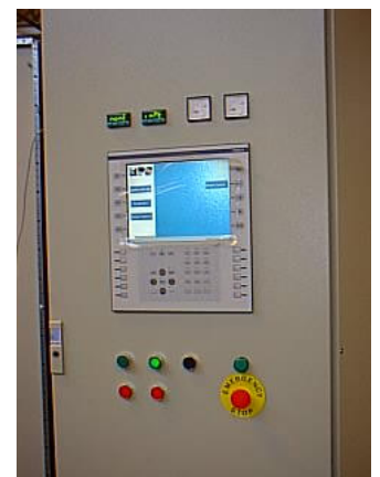
Figur 20 Elskåpets framsida med operatörspanel, temperaturregulatorer, amperemeter, manövreringsknappar och nödstopp.
