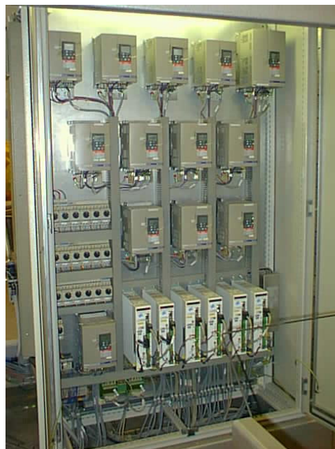
Figur 19 Elskåp 2 med frekvensomformare, motorskydd och servomotorstyrningar.
