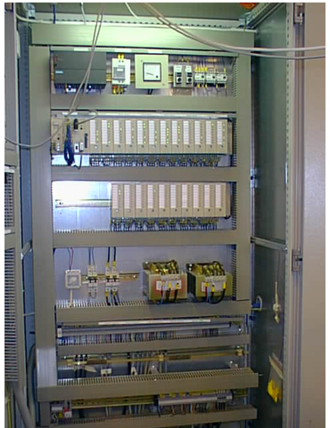
Figur 35 Elskåp 1 med spänningsaggregat, PLC samt trafo för svetsbackarna.
